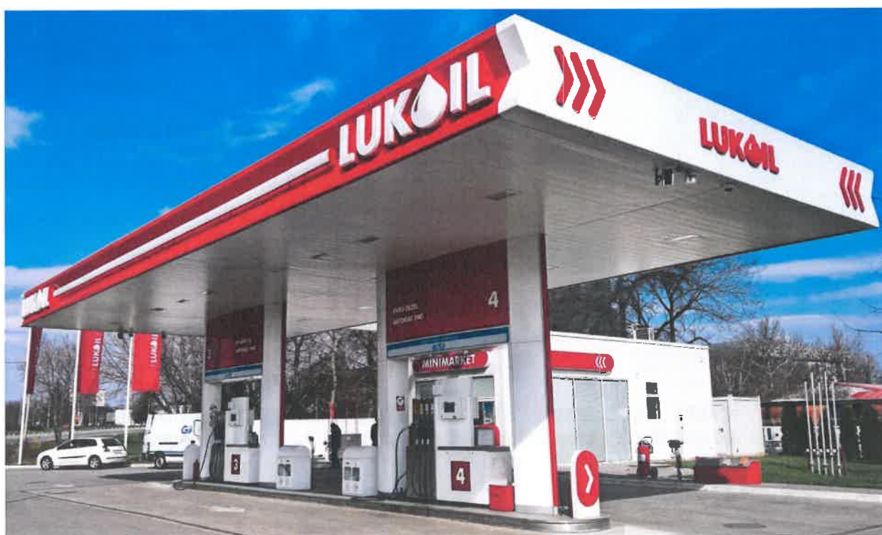
foto: čerpací stanice Lukoil Srbsko
