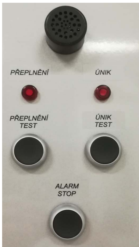
Obrázok 2 - Signalizačné prvky preplnenia a úniku
