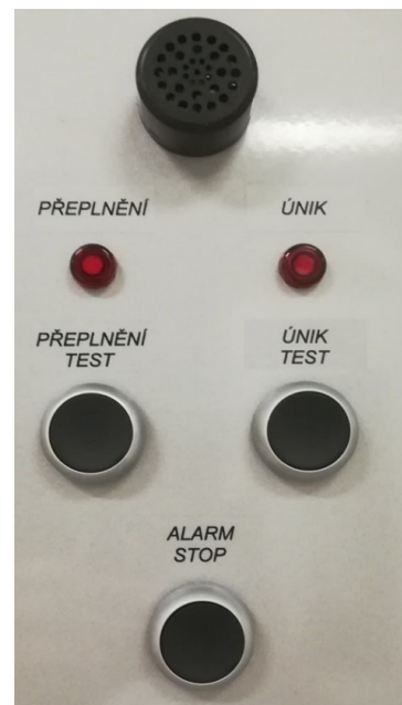
Obrázek 4 - Signalizační prvky přeplnění a úniku
