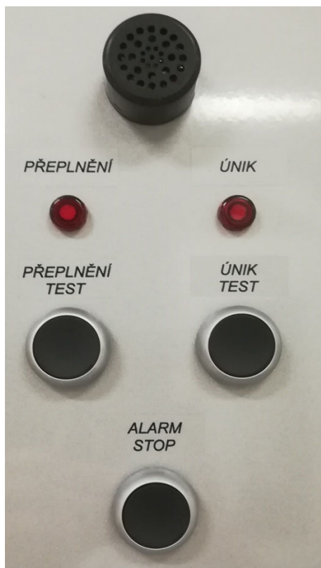
Obrázok 2 - Signalizačné prvky preplnenia a úniku
