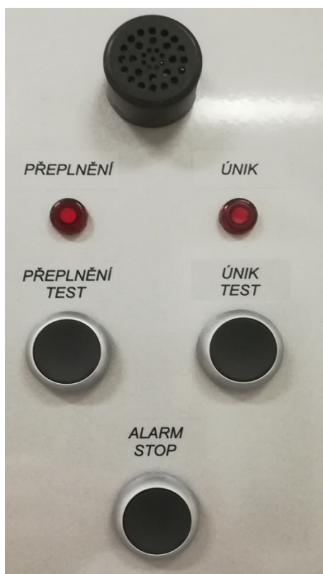
Obrázok 2 - Signalizačné prvky preplnenia a úniku
